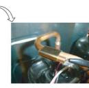
Remove the Thermistor(Discharge).
